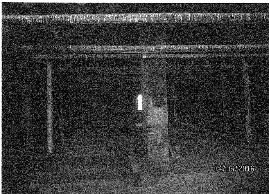
Foto Nr. 12. Jumta konstrukcijas vispārējais skats. Agrāk izpildīta pārsegumu pastiprināšana.
